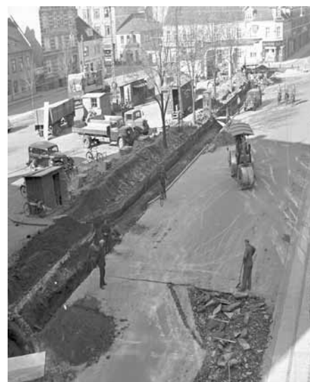
Billede: Omfattende arbejder med etablering af et fjernvarmeanlæg i Aalborg startede i 1954. Det gav både behov for rør og pumper. Fotograf J.A. Kirkegaard
