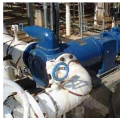
Magnetdreven Rotan ED pumpe til lukkede systemer for fenol, pesticider, benzene og andre giftige væsker.
