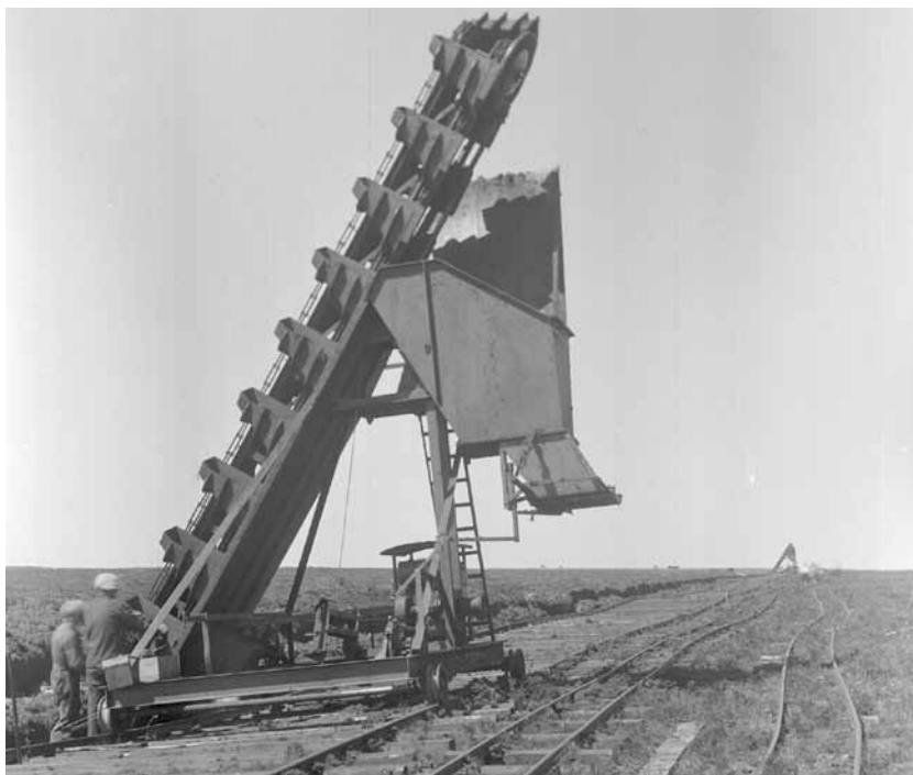
Tørvegravningsmaskine i Store Vildmose nord- vest for Aalborg i 1943. Maskinerne bredte sig over hele landet under krigen 1940-1945 og blev herefter eksporteret i stort omfang 1945-1951. Foto Karner 28.6.1946
