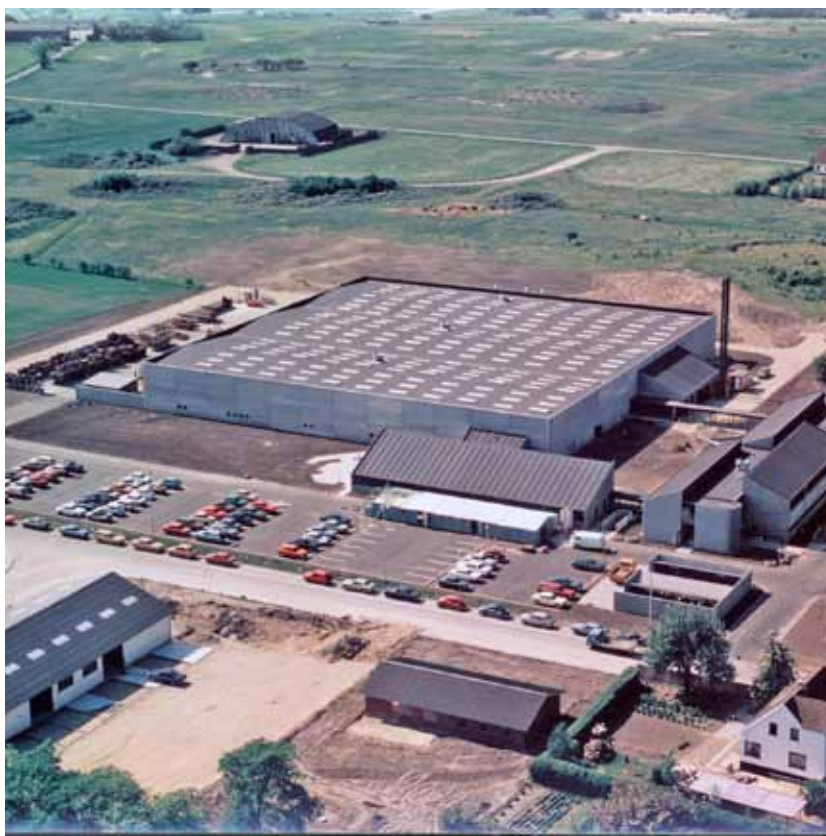
”De Smithskes” nye fabrik i Lindholm står færdig i sommeren 1978. I midten de store produktionslokaler, i front ved parkeringspladsen kantine og til højre administrationsbygningen. At fabrikken ligger tæt på Aalborg lufthavn fremgår bl.a. af hangarbygningen i baggrunden. Ukendt fotograf 1978.
