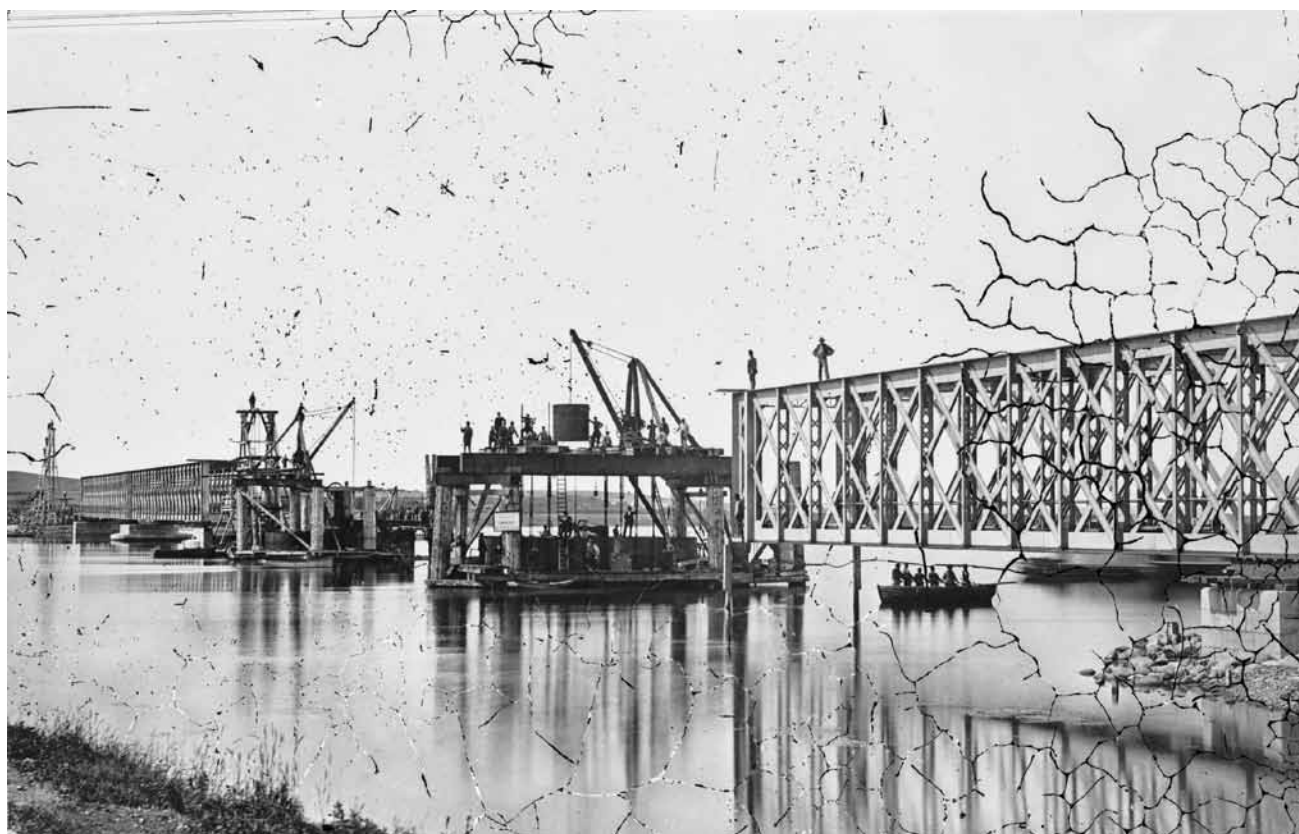
Jernbanebroen over Limfjorden der her er fotograferet under bygning af Heinrich Tønnies i 1875 forbandt jernbanen op gennem Jylland med banen gennem Vendsyssel. Selvom den blev bygget af et fransk ingeniørfirma gav den store bestillinger til "Smithske"
