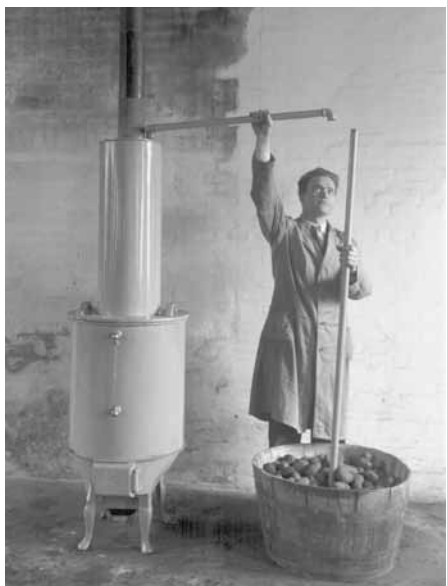
En række særlige produkter opstod under 1940'ernes mangelsituation. Øverst en "kartoffelkoger" på damp, nederst det særlige "sparekomfur" der kunne opvarmes med tørv og lignende dårlige opvarmningsmidler. Foto Fritz Karner, 1941.
