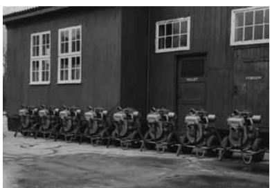
Små horisontale selvansugende centrifugalpumper til beredskabs- og forsvarsformål 1947.
