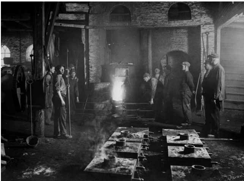
Formere og arbejdsmænd venter på at det flydende støbejern løber ud af kupolovnen og står parat med formene, hvori støbejernnet "formes" til det man ønsker sig. Sådan som det uden afbrydelse var sket på dette sted i Algade i Aalborg i mere end hundrede år fra 1834 til 1935. Fotograf H. Tønnies 21. december 1935
