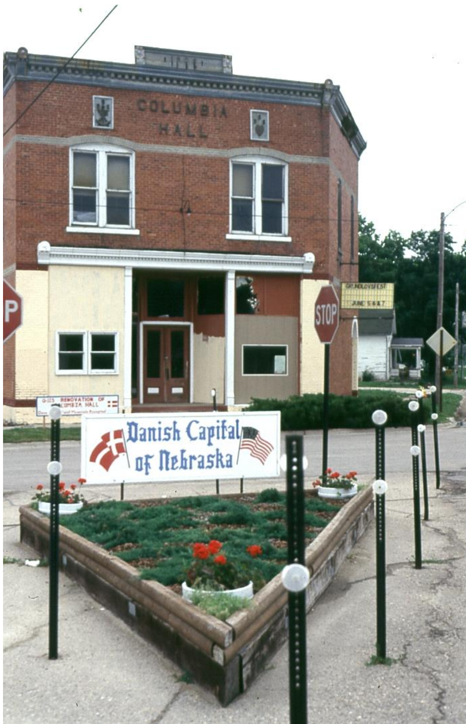
DANISH CAPITAL OF NEBRASKA. Torvet i Dannebrog med "Columbia Hall" opført i 1904 af bygmester H.C. Rasmussen (1853-1937), født i Kjettinge på Lolland. Foto HB 1991
