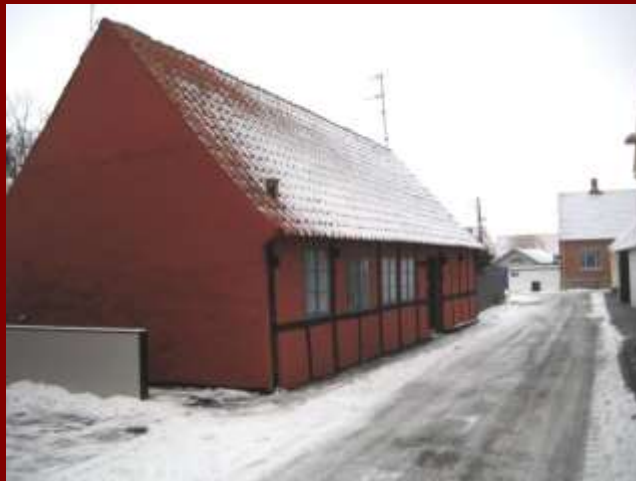
Ferskesøstræde 6, Nexø. 1885 og 2010
