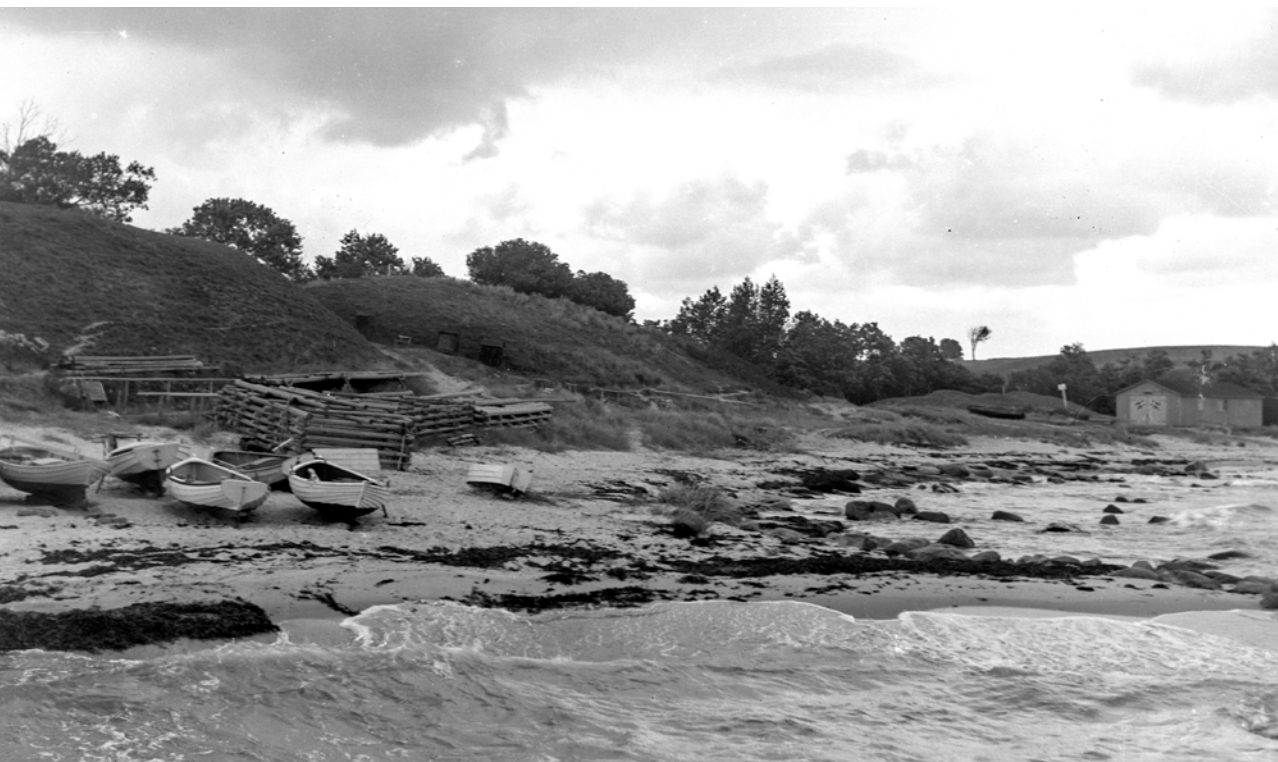
Redningsstation med båd i Boderne Havn skimtes th., en redningsstation som senere blev vandrerhjem. Redningsstationen, der oprettedes da der var så langt mellem Snogebæk og Rønne, skulle betjenes af begge stationer efter behov. Da der ikke blev tale om redningsaktioner overhovedet blev den atter nedlagt 1932. Fotograf ukendt.
