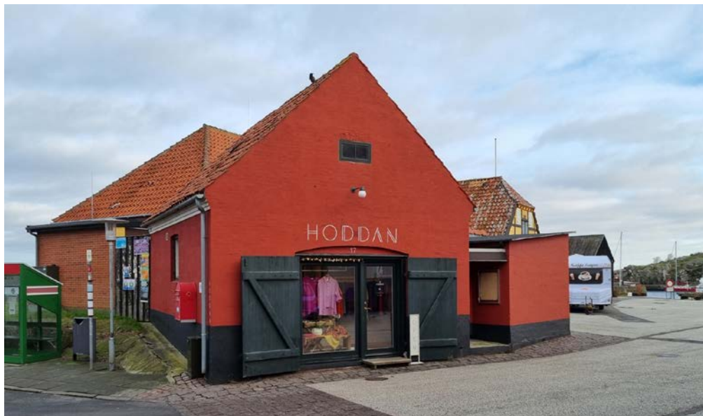
Gudhjem Raketstation, der startede i 1852 fik i 1920 egen bygning. I brug til 1976. Ejnar Mikkelsens vej 17, Gudhjem. Stationen gennemførte 1858-1954 i alt 12 redningsaktioner og reddede 94 menneskeliv. Nu tøjbutik »Hoddan«, Foto Henning Bender 2022.
