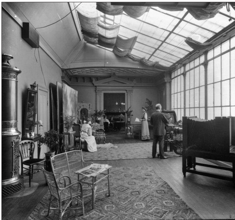
Fig. 7. Atelieret på Nytorv indefra omkring 1895. Emil Tønnies står med ryggen til og foran ham det store kamera, der blev brugt til udendørs optagelser. Fra unummereret orginilanegativ. Aalborg Stadsarkiv.
