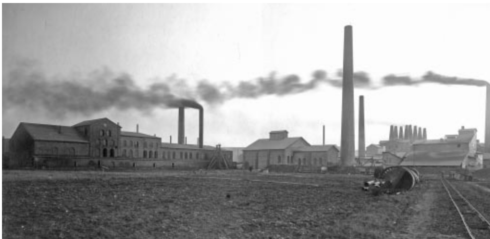
Aalborg Portland 1899 med det første roterovnhaus fra 1899 til venstre og det tilhørende kedelhus i midten. Til højre i baggrunden ses fabrikkens ældre bygninger med skaktovnhusets karakteristiske profil.
