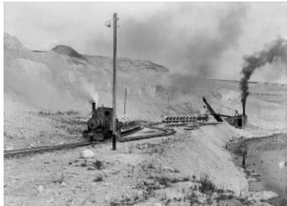
Dampdrevet gravemaskine og tipvognstog i Aalborg Portlands kridtgrav 1930.
