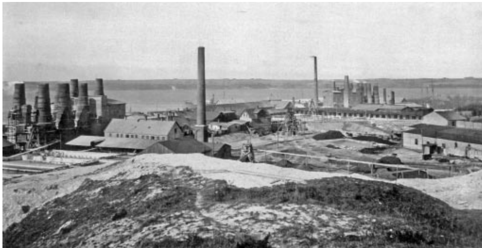
Fotografi af cementfabrikken Dania o. 1900. Til venstre ses den ene af fabrikkens to ovngrupper med tilhørende udvendige elevatorsystemer. I baggrunden ses den anden ovngruppe bag cementmølleriet og en række tørreskure.
