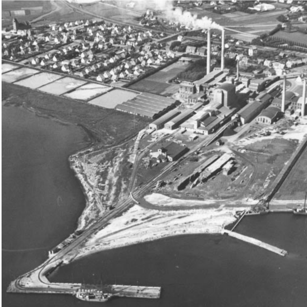
Dansk Andels Cementfabrik midt i Lindholm. 1938.
