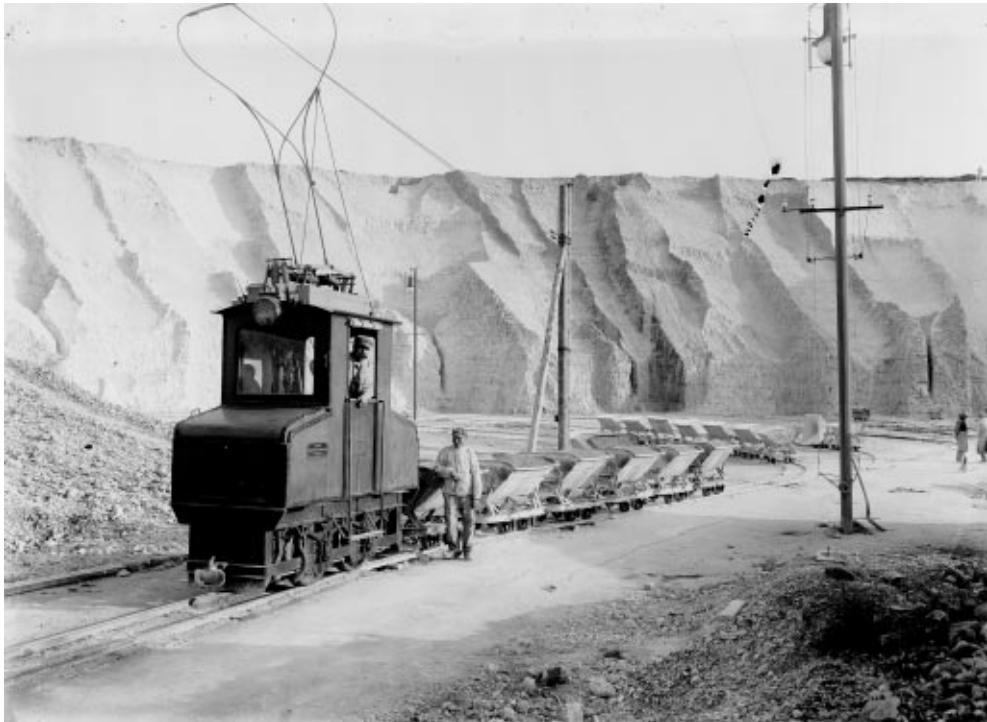
Kridtgraven på Rørdal med det nye eldrevne tipvognstog. 11. september 1910. Det sparede megen muskelkraft.
