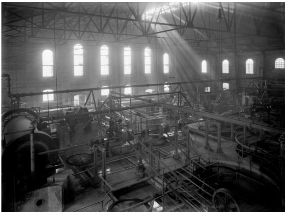
Slemmeriafdelingen i Aalborg Portlands andet roterovns hus fra 1908. Billedet er taget fra en platform ved roterovnenes øvre ende, hvor skorstenene blev ført op gennem den buede tagkonstruktion. Gavlpartiets høje vinduesåbninger er den fremadstormende teknologi værdige.
