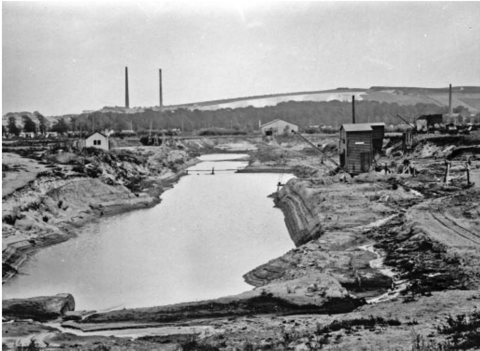
Fabrikken Danmarks lergrav 1921. Slemmeriet, hvorfra leret pumpedes i en rørledning til fabrikken i baggrunden, ses ved lergravens modsatte ende.
